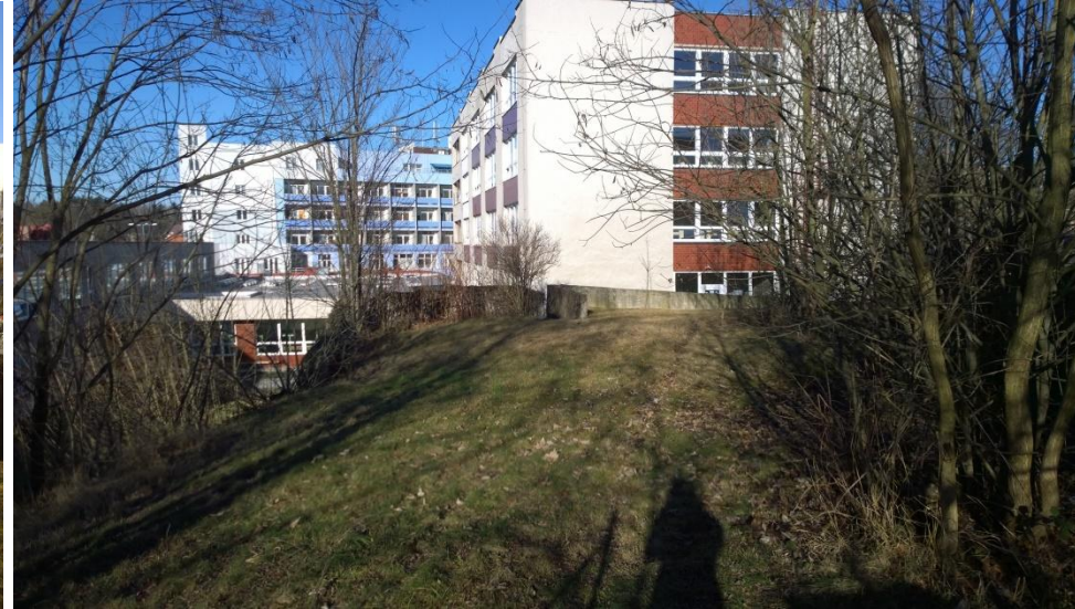
horní zahrada celkový pohled v pozadí budovy ubytoven
