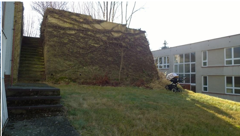
schodiště na horní zahradu
