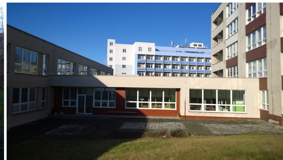
pohled na předprostor jídelny s hlavním vstupem do zahrady
